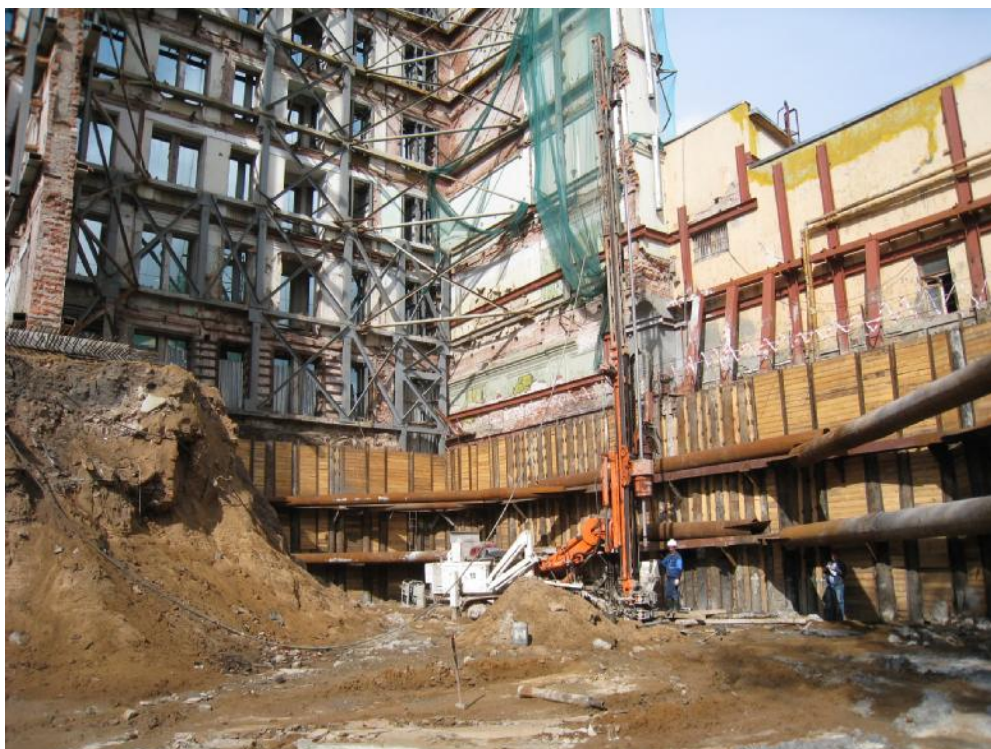
Фото 1. Реконструкция здания по ул. Малая Никитская в Москве.
