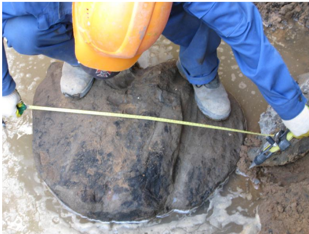
Фото 2. Грунтоцементная свая
